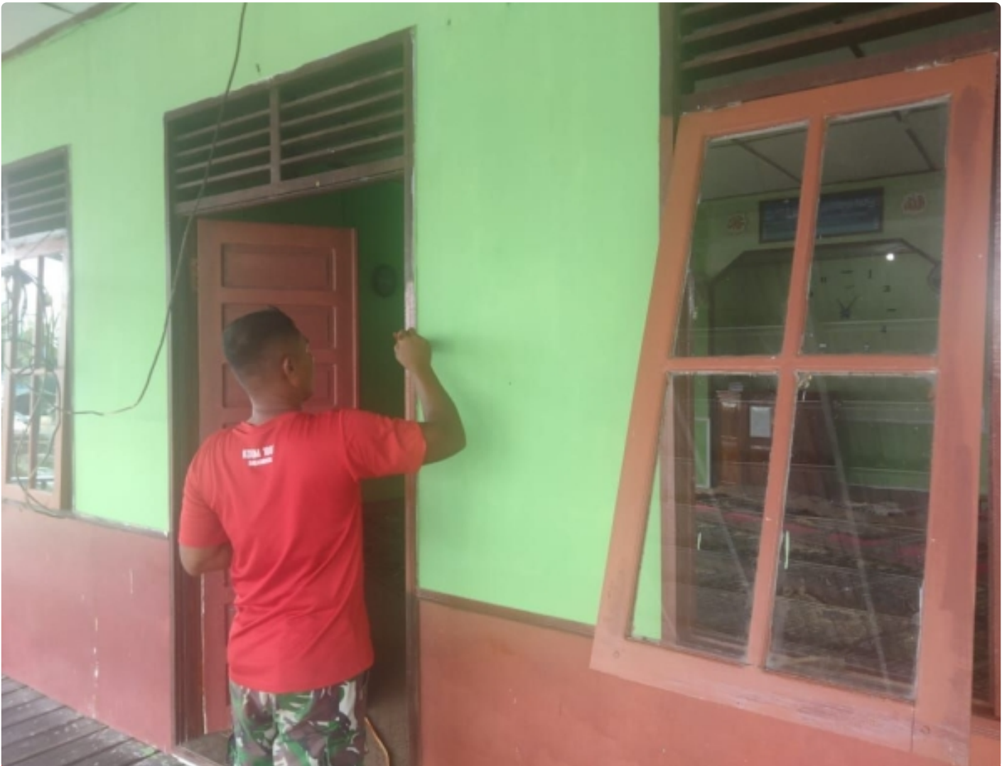
Sasaran Fisik TMMD Kodim 1001/HSU-BLG BLG capai tahap pengecatan Dinding Masjid Jami Al Hidayah
