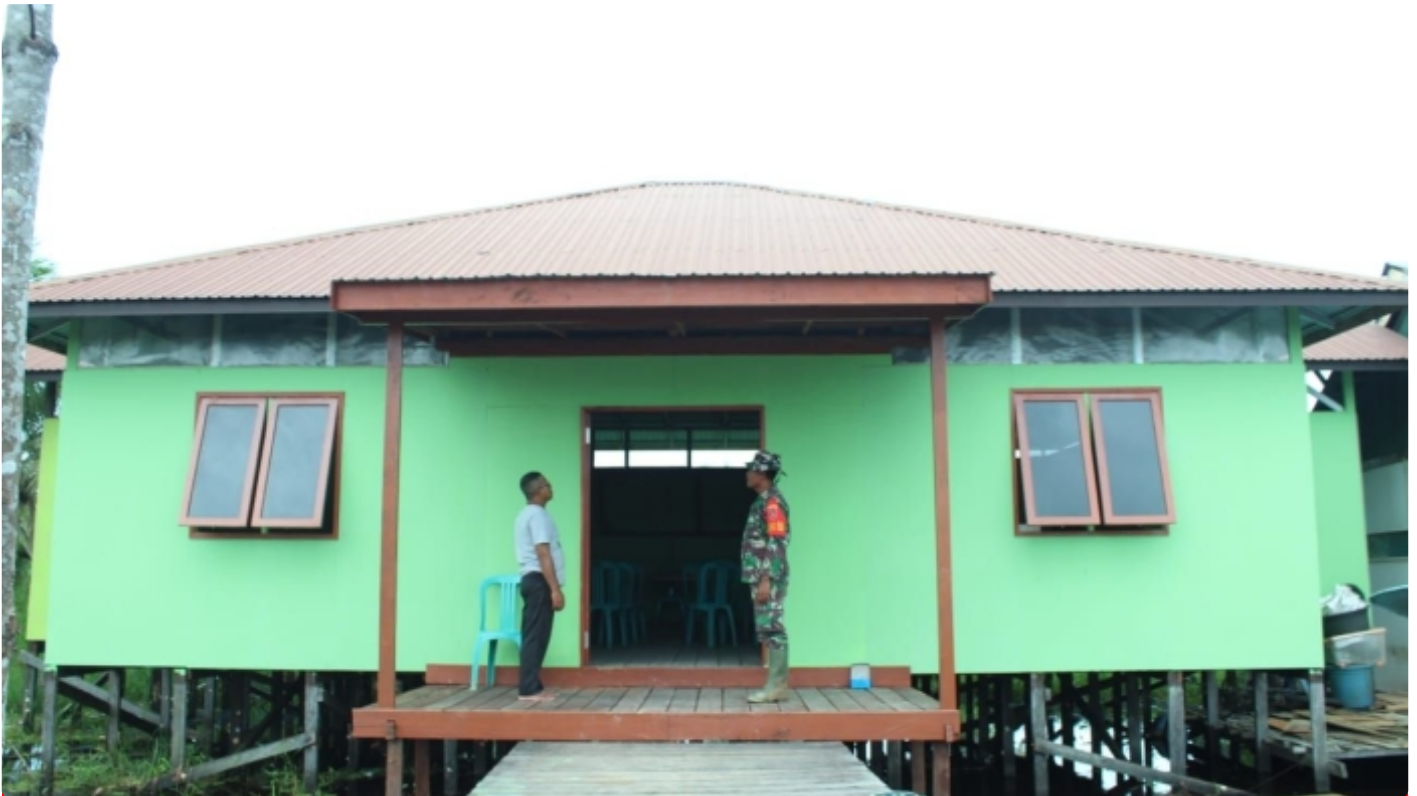
Rehab Balai BPD Rampung 100 Persen
