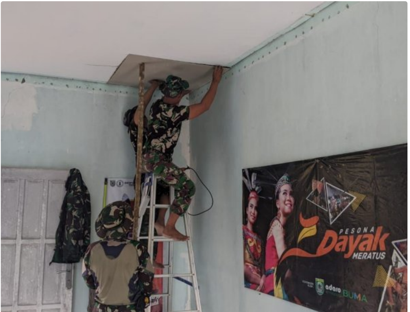
Kodim 1001/HSU-Balangan Rehap Kantor DAD Kabupaten Balangan
